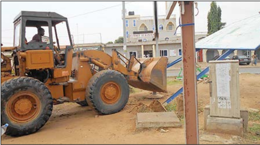
Démolition d'une pancarte
