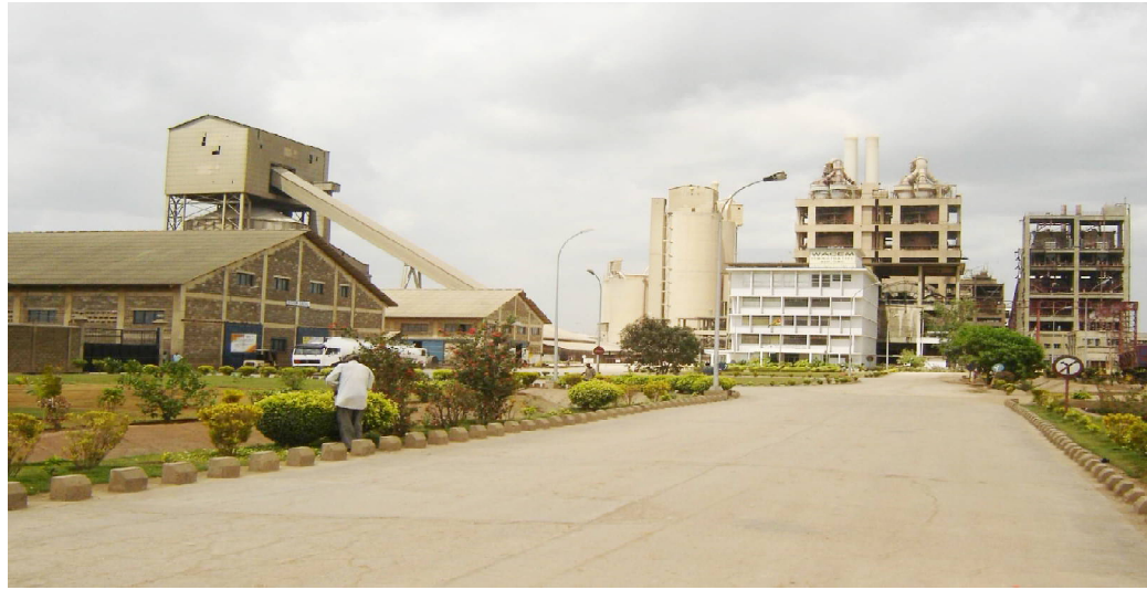
Vue de l'usine de cimenterie de WACEM
