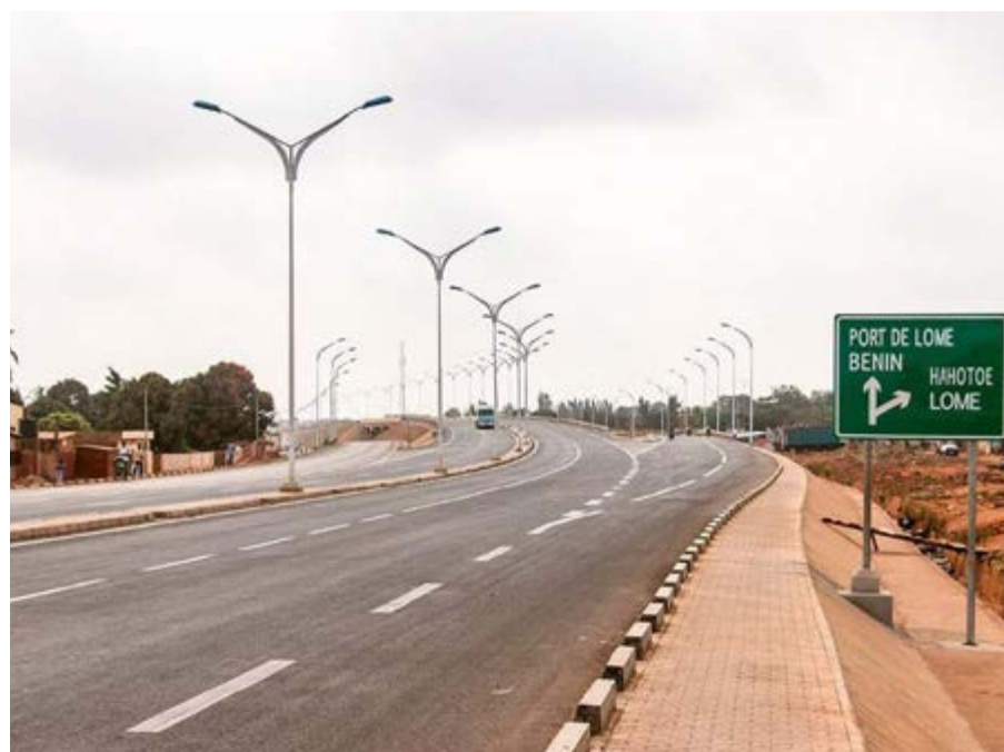
Vue partielle de la voie du grand contournement
