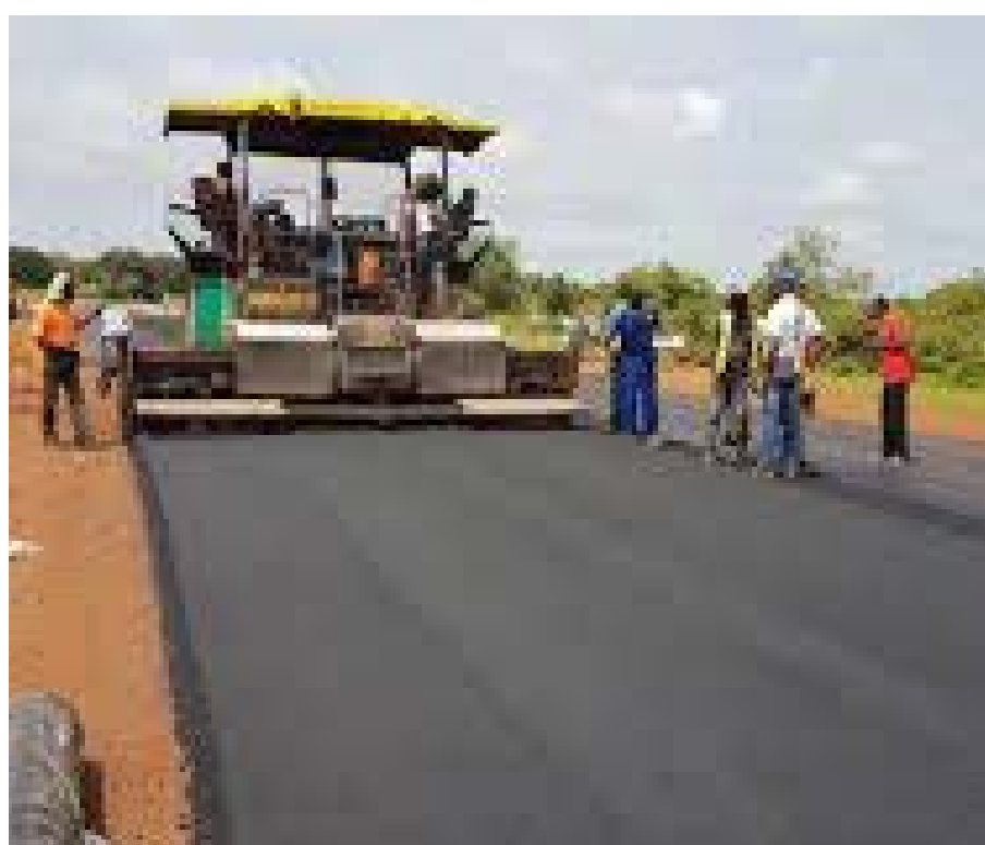
Rehabilitation d'une route
