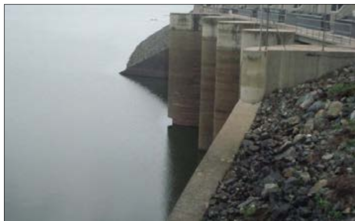
Un aperçu du barrage de Nangbéto
