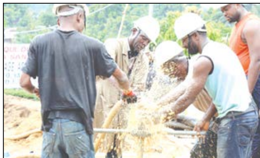
Réalisation manuelle d'un forage
