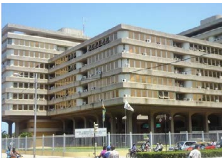
Centre administratif et des services économiques et financiers (Casef)
