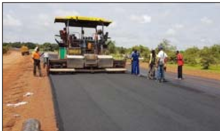
Une route en construction (Archives)
