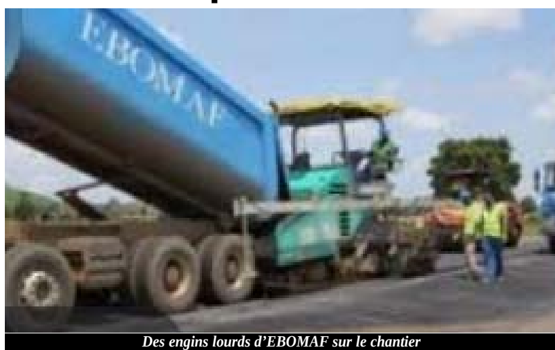
Des engins lourds d'EBOMAF sur le chantier
