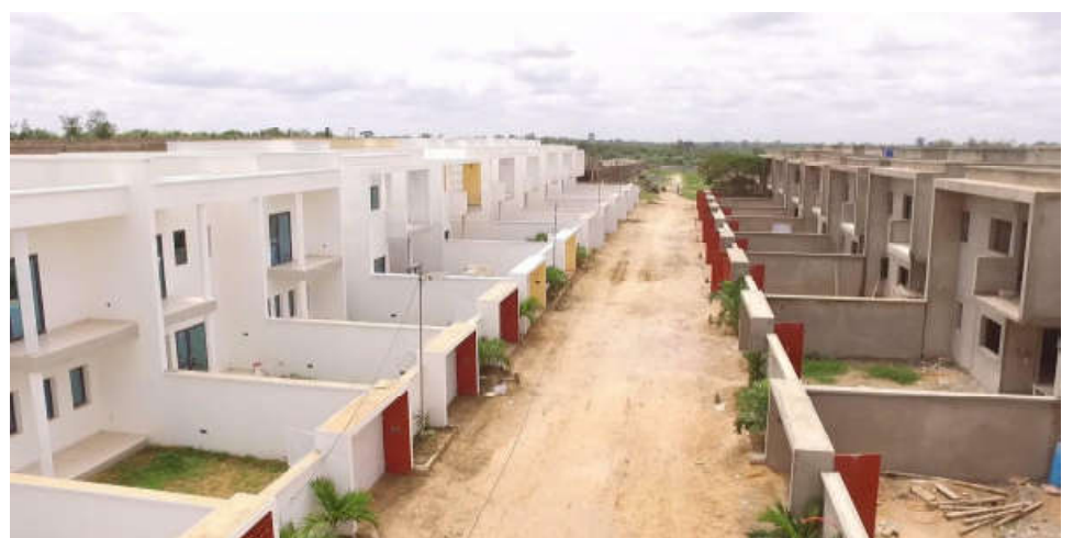
Des logements sociaux en construction
