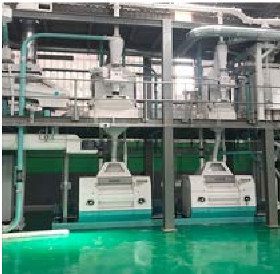
Aperçu de l'usine de transformation de maïs sise à Tsévié
