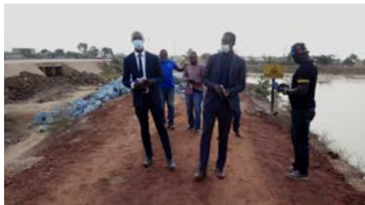
Les officiels sur le chantier
