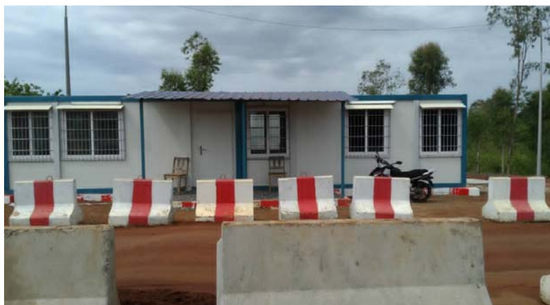
Le poste de péage de Zanguéra avant les travaux...
