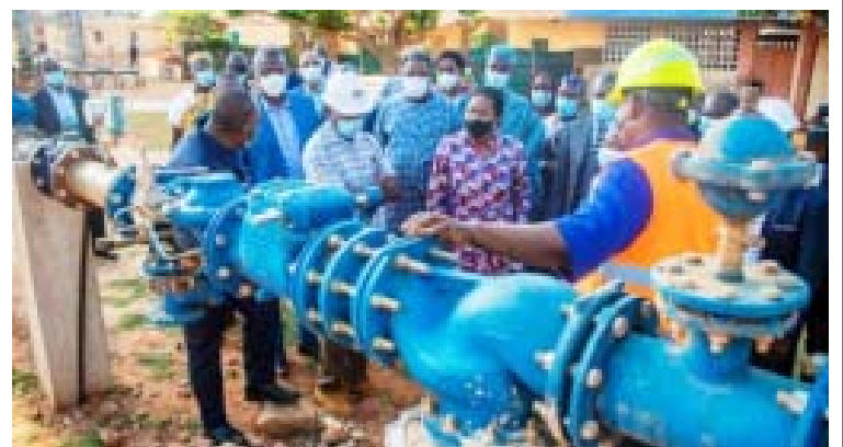
Mme Victoire Tomégah-Dogbé visitant un site en construction de château d'eau
