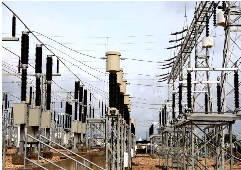
Les installations de la centrale photovoltaïque
