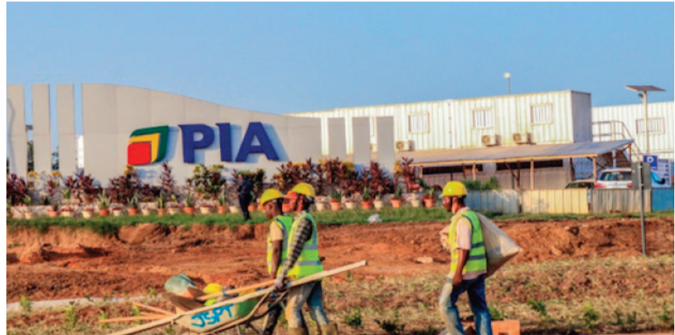
Site de la Plateforme Industrielle d'Adetikopé (PIA)
