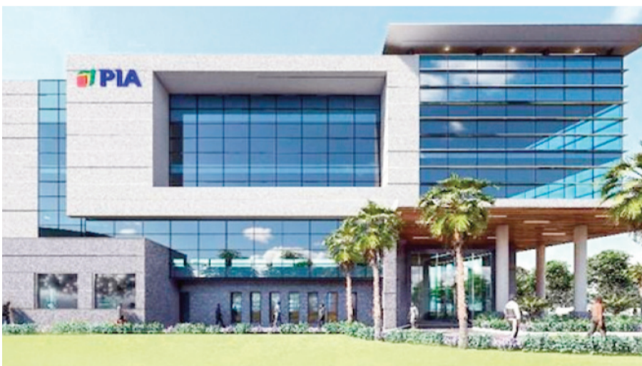
Vue partielle du bâtiment principal
