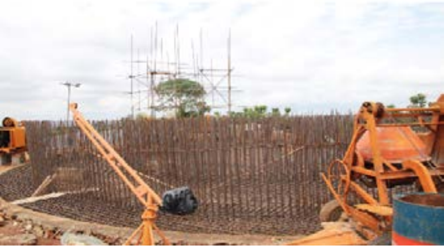
Aperçu du chantier de château de 1 000 m³
