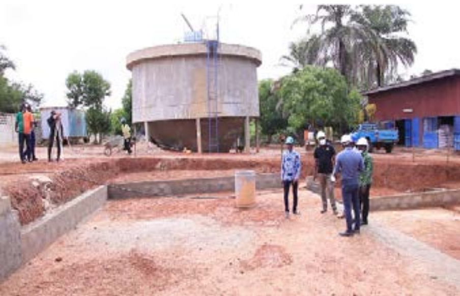
Travaux en cours de réalisation à l'UTEP de Sokodé
