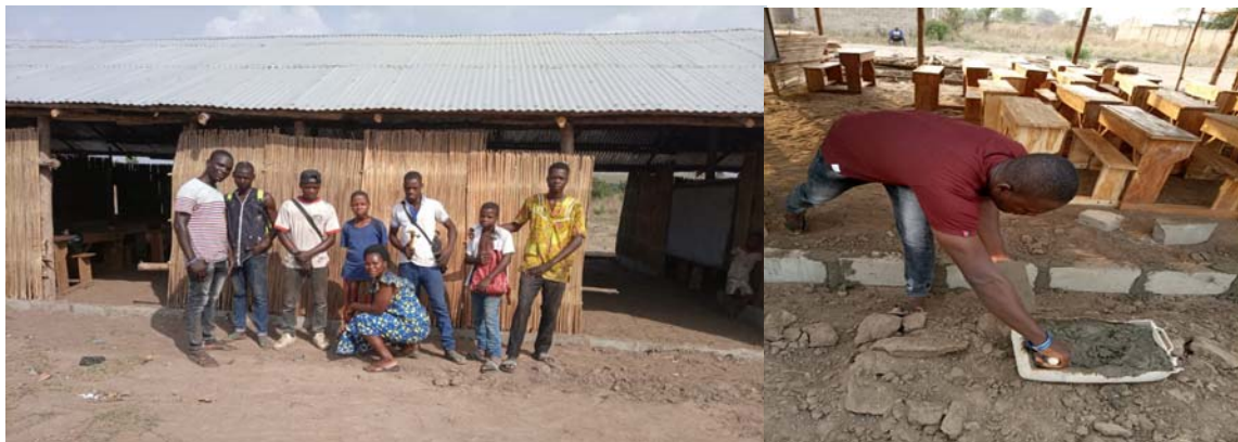
Les membres de l'association en pleine construction du seul bâtiment de l'EPP FIDA-Notsè
