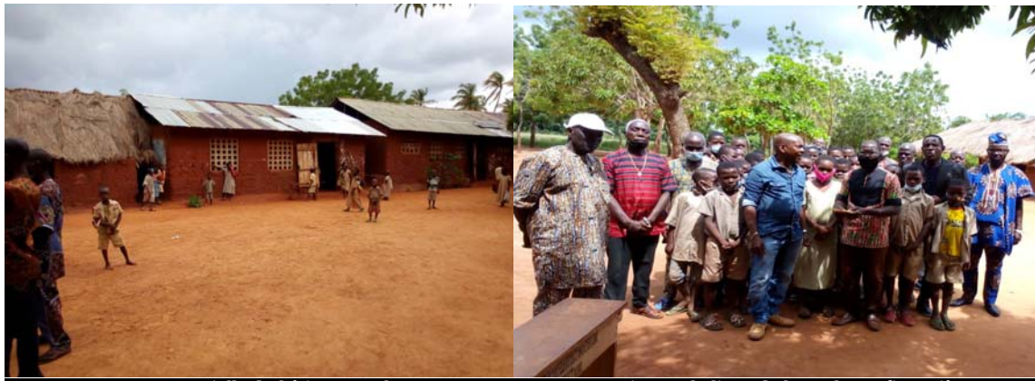
Une vue partielle du bâtiment en banco
