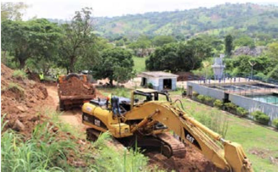
Aperçu des travaux de renforcement du barrage de la Kozah
