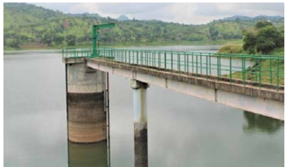
Barrage de la Kozah
